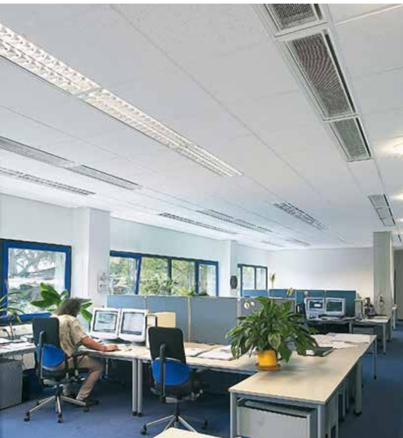
Viga fría activa de techo. Existen configuraciones muy variadas, incluso integrando luminarias.
